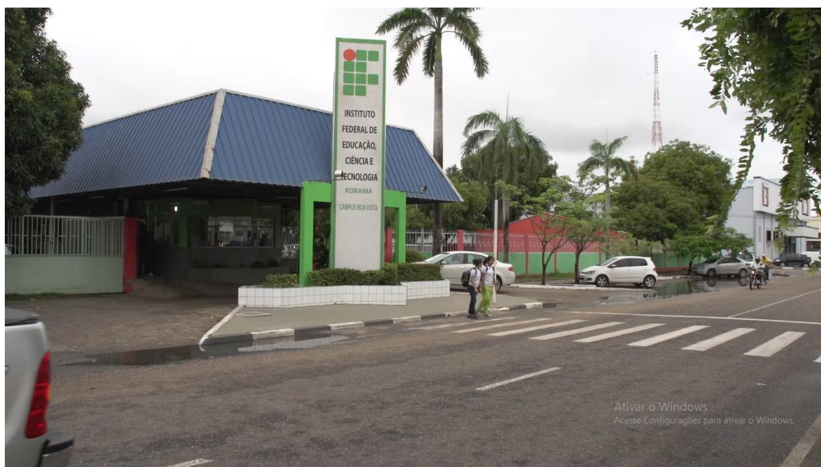
Figura 3. Fachada do Instituto Federal de Roraima (IFRR) que aparece no documentário.
