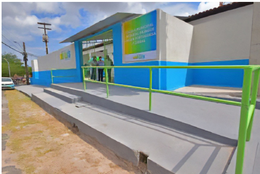
Foto 28 – Fachada da Escola Bilíngue de Surdos de São Luís.
