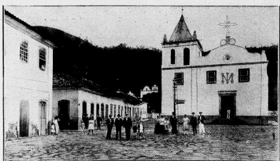
A Igreja matriz de Angra dos Reis. Ao fundo, o convento de S. Bernardino.
