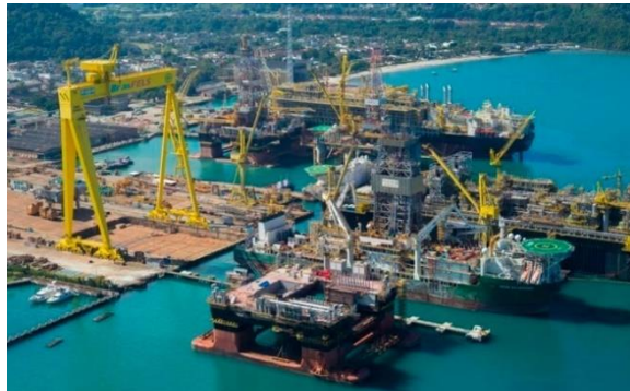
Figura 40: Estaleiro 19 https://www.portosenavios.com.br/noticias/ind- naval-e-offshore/modec-contrata-seatrium- fabricacao-de-modulos-topside-de-fpso-em-angra- dos-reis
