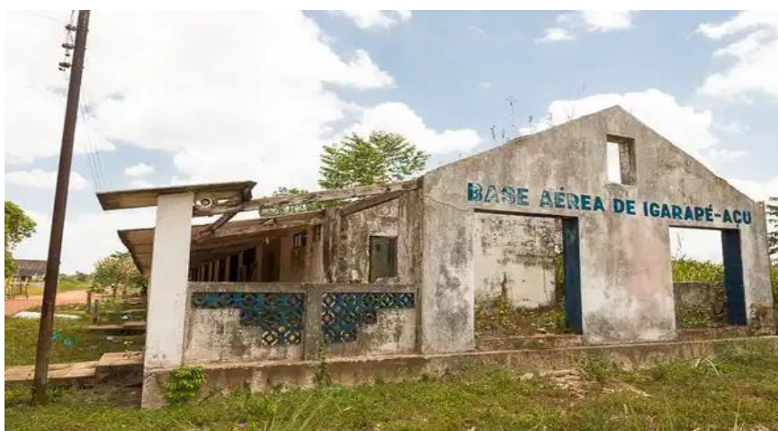
Imagem 17 – Antiga base aérea de Igarapé-Açu
