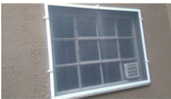
Figura 58 - Telas para área de alimentos - GRADE
