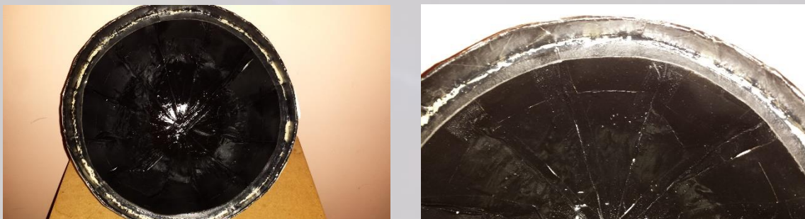
Figuras 14 e 15: Detalhe dos aros colados na base da cúpula externa
