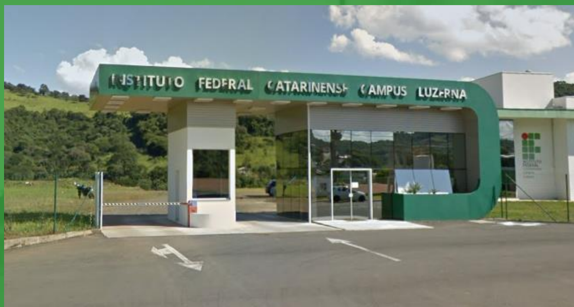
Figura 10: Guarita do campus Luzerna do IFC. Promove-se, por meio da arquitetura, a integração do campus ao seu entorno.
