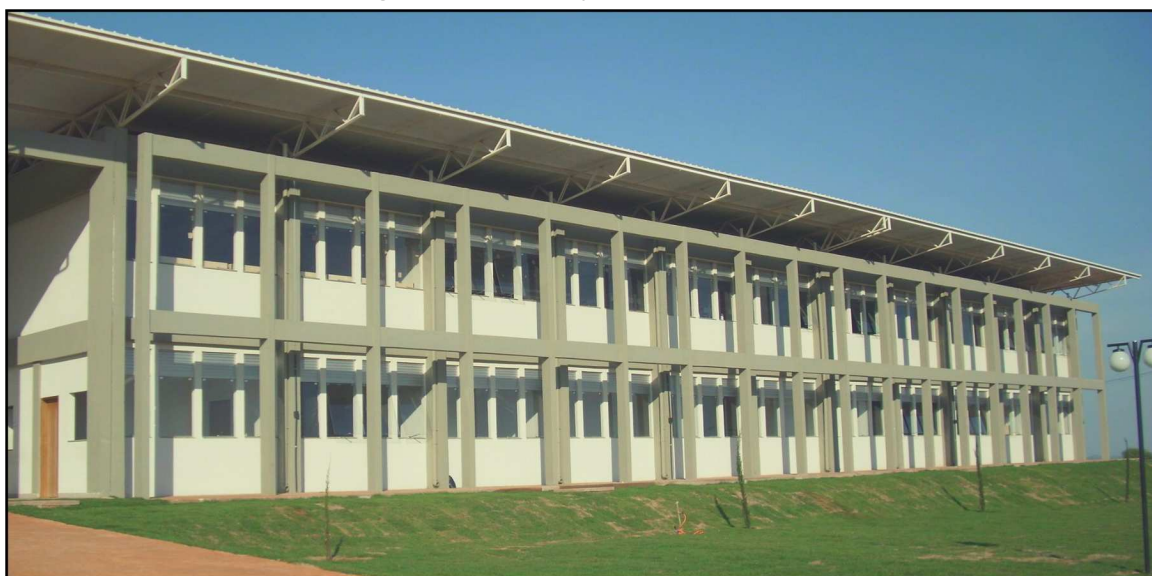
Figura 2 - Construção do IFG-Anápolis
