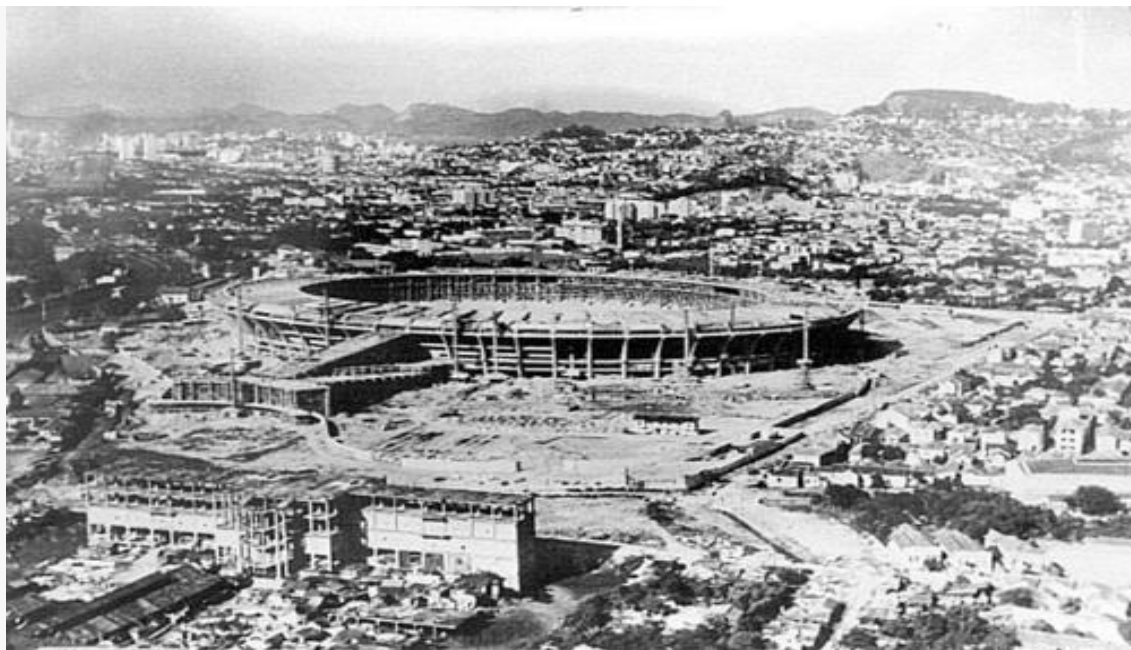
Figura 10: Construção do Estádio do Maracanã (1949). Fotografia encontrada no livro Rio de Janeiro-uma viagem no tempo, de Fernando da França Leite.
