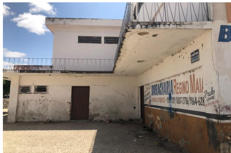
Figura 20: Vista fachada sul antigo Hotel Municipal
