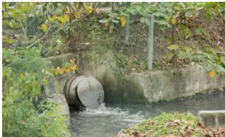
Figura 9: Despejo de esgoto no Recreio, Zona Oeste do Rio Foto: Analice Paron / Agência O Globo/04-07-2017 5
