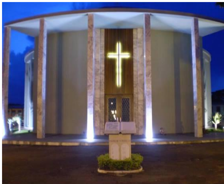
Foto 4: Igreja Matriz São Sebastião Atual - 2019
